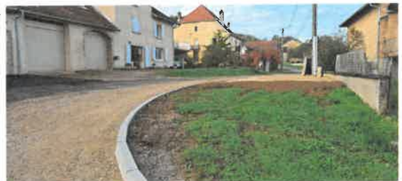
Place du Monument : pose d'un enduit bicouche, pose de bordures de trottoirs et pose d'une grille en fonte.
