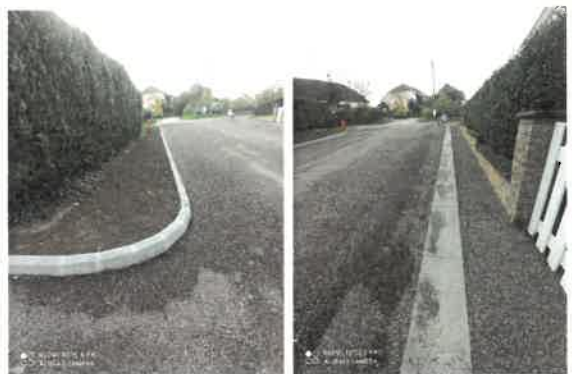
Rue du Souvenir : création de fossé, pose de caniveaux, pose de bordures de trottoirs et enduit bicouche.
