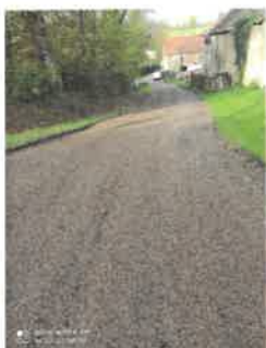
Rue du Creux : pose d'un enduit bicouche Montant HT des travaux : 3 178.25 €
